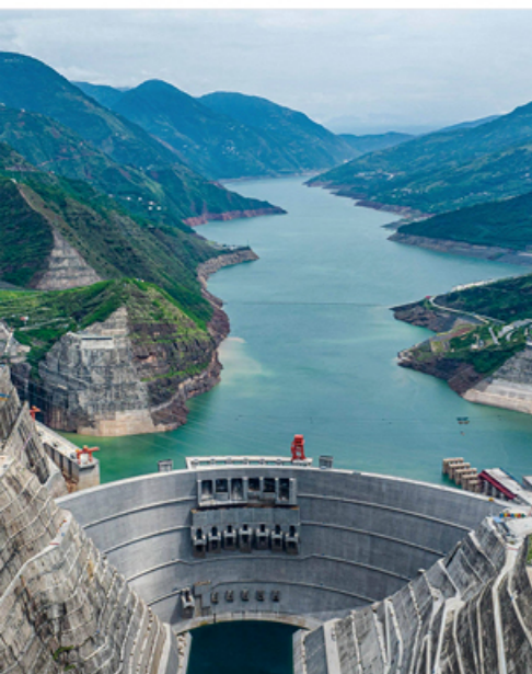
白鹤滩水电站
